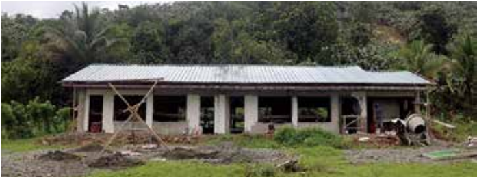
建設中のアルサビ小学校校舎（2教室とトイレ）
